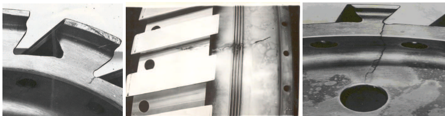
Рис. 1. Фотографии трещин в дисках компрессора
